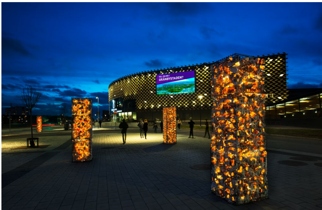
Gabioner, Gränby Köpstad, Uppsala.
